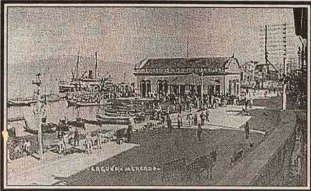
Mercado Público de Laguna antes de ser destruído pelo fogo em 20/8/1939.
